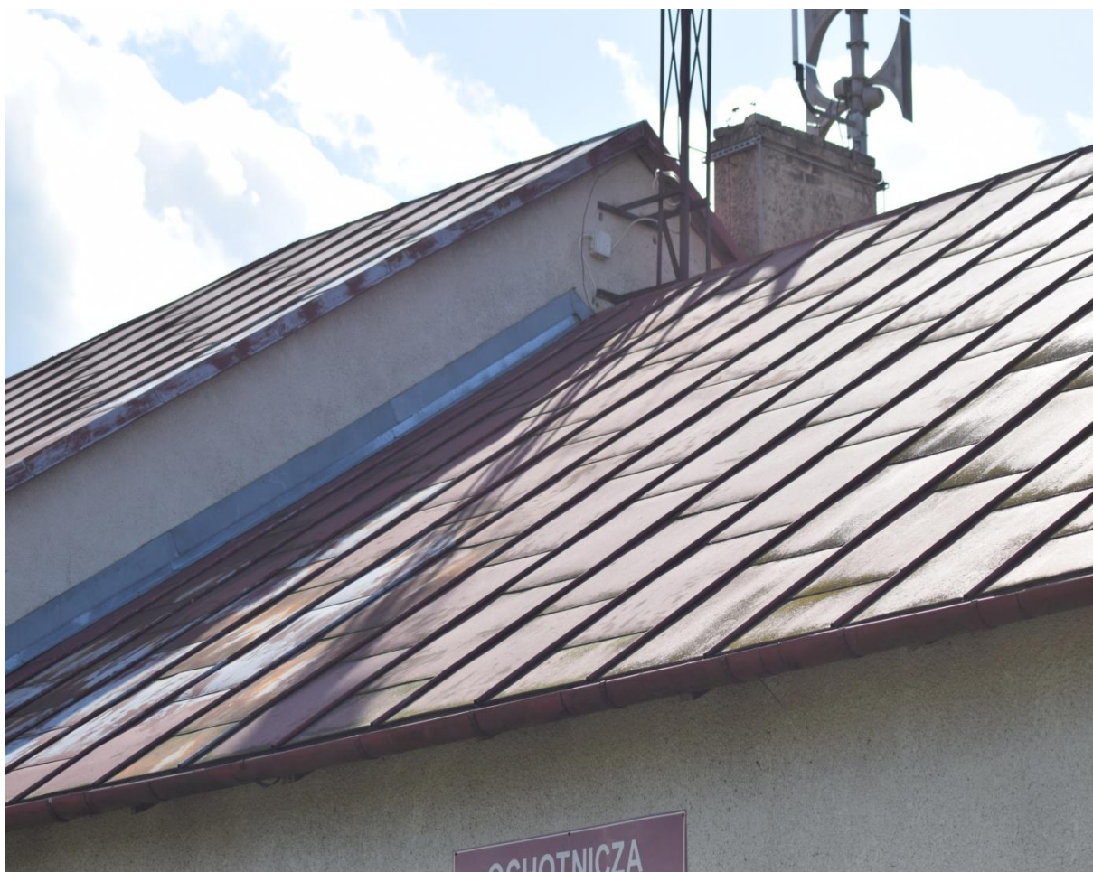
Fot. 7. Dość dobry i szczelny stan poszycia dachu i wykończeń dekarских badanego budynku.
